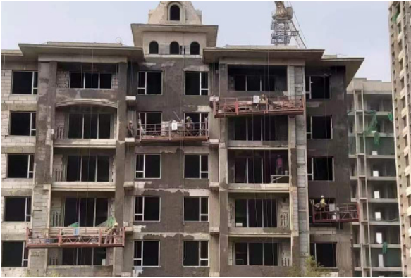
藁城天山熙湖 如火如荼抓建设 高效施工保进度
