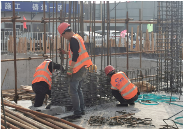
天山建筑公司施工
