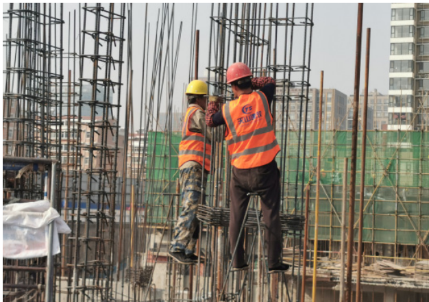
天山建筑公司施工
